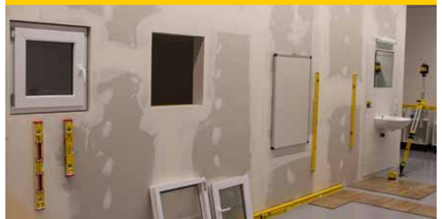
Vielfältige Innenausbau-Arbeiten wie Fenstereinbau, Fliesenlegen, Elektro- und Sanitärinstallation werden an der Trockenbauwand veranschaulicht.
