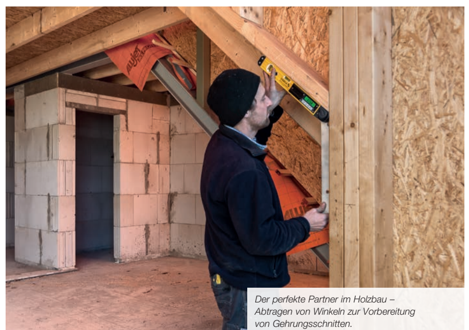
Besonders geeignet für Schreiner- und Tischlerarbeiten – Ermitteln und Übertragen von Winkeln, zum Beispiel beim Küchenbau oder beim Ausrichten sonstiger Einbaumöbel.
