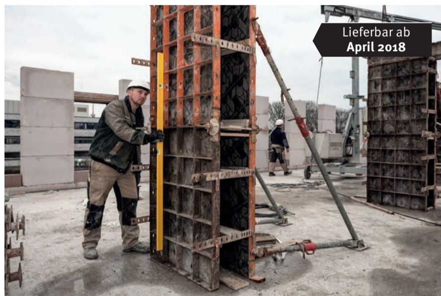
Kunststoff-Endkappen schützen das Profil bei Schlägen.
