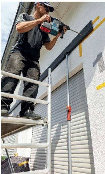
Die GS zertifizierte Deckenstütze STE300 mit 1.700 – 3.000 mm Verstellweg und 3,8 kg Eigengewicht kann je nach Auszugslänge zwischen 350 und 110 kg belastet werden.
