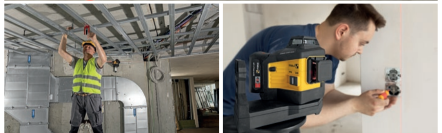
Die roten Linien des Multilinen-Lasers LAX 600 sind dank Hochleistungsdioden bis zu 30 m sehr gut sichtbar. So ist effizientes Nivellieren in der horizontalen und vertikalen Position zur gleichen Zeit möglich.
