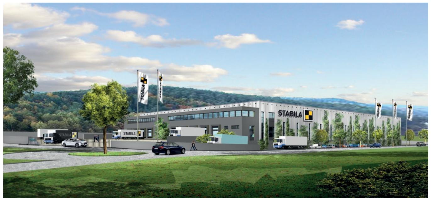
Ansicht des neuen Standorts, den STABILA bis Anfang 2024 im Gewerbegebiet Wilgartswiesen / Hauenstein errichtet.
